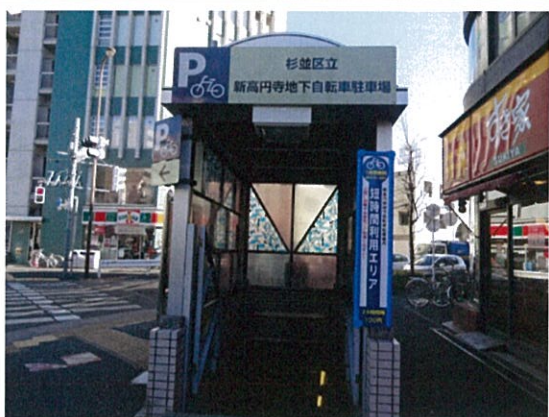
新高円寺地下自転車駐車場
