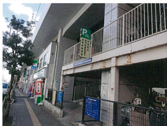
高円寺東高架下自転車駐車場
