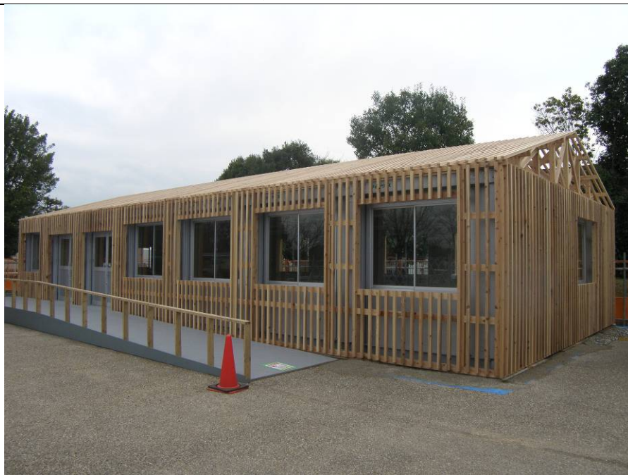
整備工事完了時
