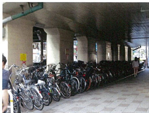
高架下駐輪場(M)
