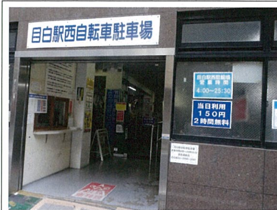
目白駅西自転車駐車場
